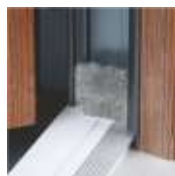
ветростоп- дополнительное уплотнение
